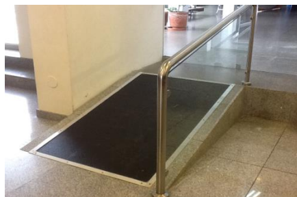
Rampa interior en Regional Santa Cruz
